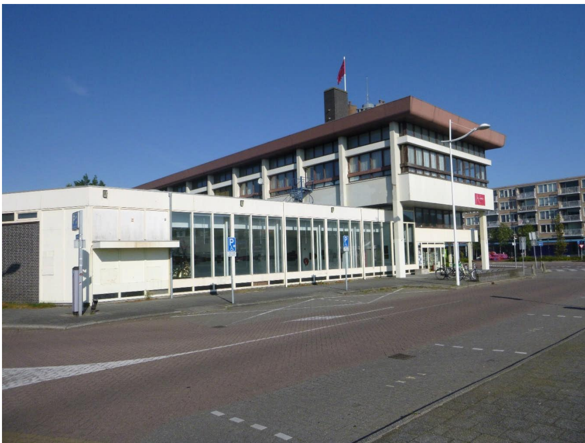
Foto voorgevel Middenweg 174 te Den Helder
