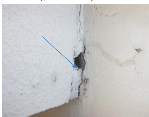
Foto 13 - Kit tussen gevelpanelen (geen asbest)
